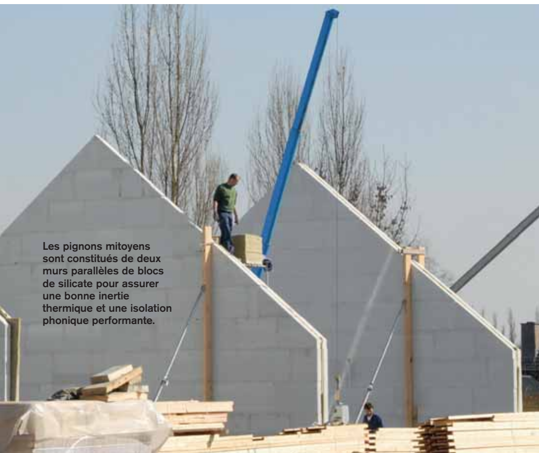
La structure du pignon de la maison P20. Les caissons de bois seront insufflés de ouate de cellulose.
